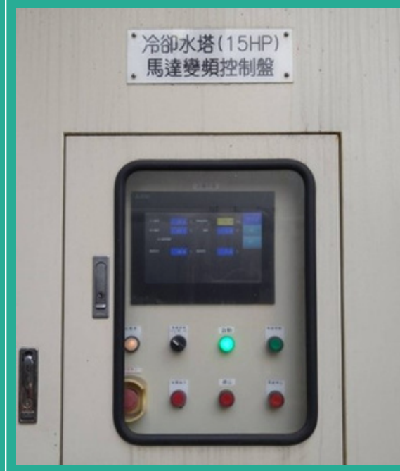
冷卻水塔風扇增設變頻控制系統
